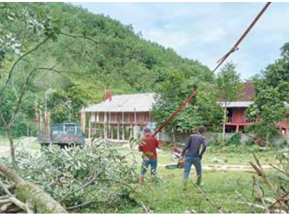
写真：クーヴァン分校（ベトナム）建設中
