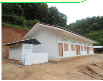
先月建設が完了した新校舎
