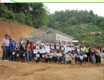
建設中の校舎をバックに
