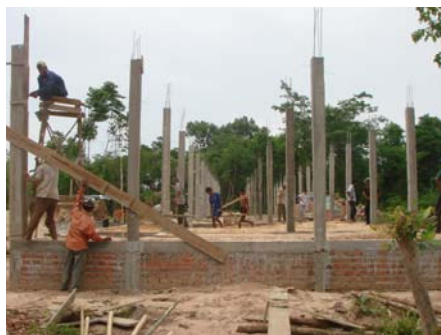
基礎が完成、柱も立っています(2009年5月撮影)
