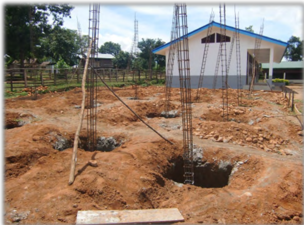
建設が進むパチュドン高等学校
